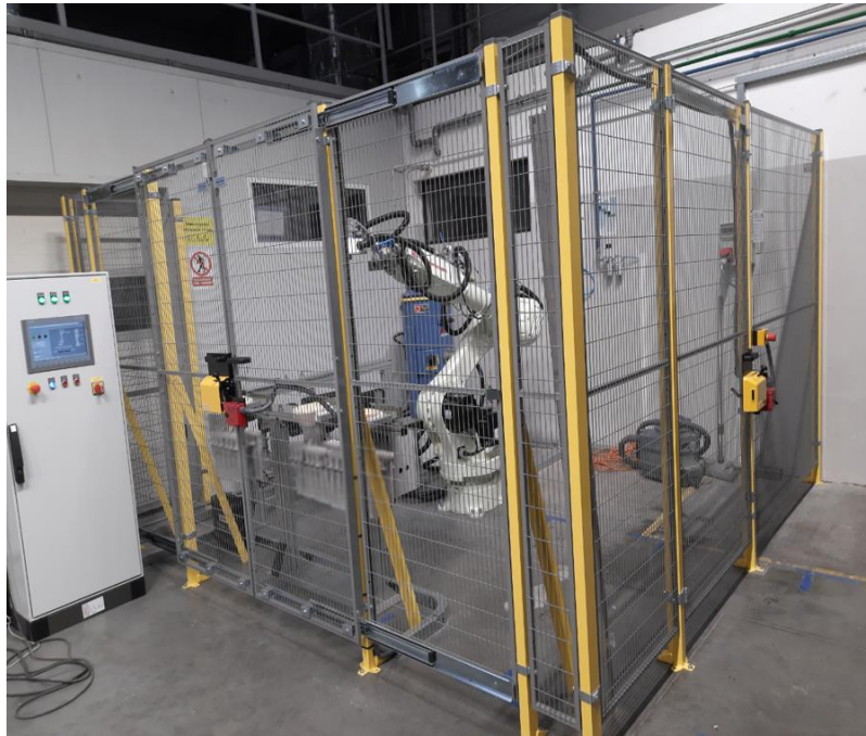
Rys. 4.26. Zdjęcie stacji zrobotyzowanej podczas prac montażowych
