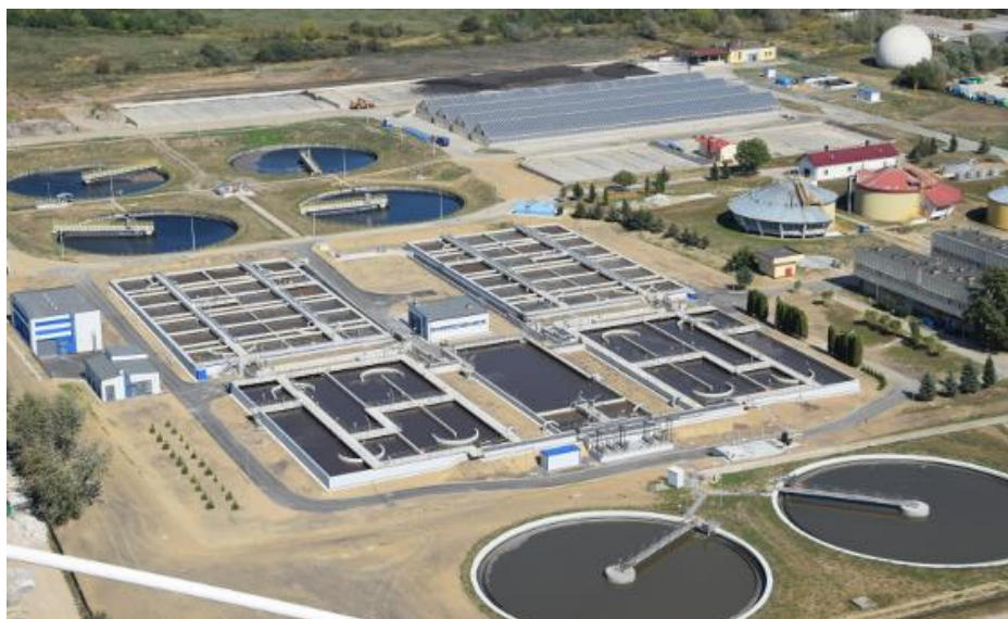
Rysunek 7. Widok na oczyszczalnię ścieków w Rzeszowie źródło: [368]
