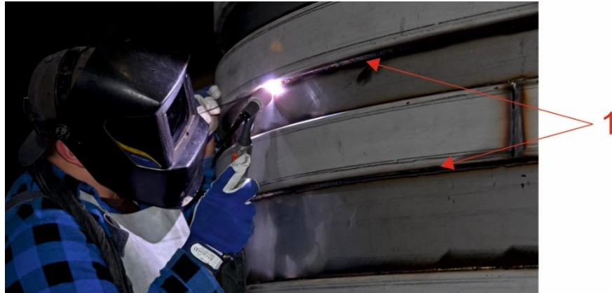
Rys. 3. Łączenie techniką spawania (metoda TIG) ceownika do powierzchni zewnętrznej płaszczu wewnętrznego zbiornika, 1 – spoiny montażowe
