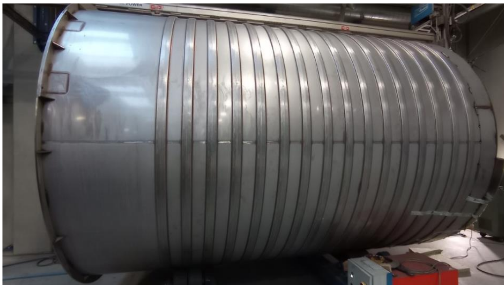
Rys. 31. Widok zbiornika wykonanego na zautomatyzowanym stanowisku spawalniczym do wykonywania wężownic przed operacją trawienia i pasywacji spoin oraz montażem izolacji i płaszczu zewnętrznego
