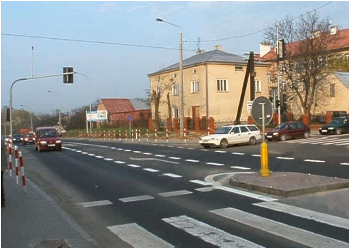
Rysunek 7. Widok tarczy skrzyżowania po przebudowie (fot. własna).
