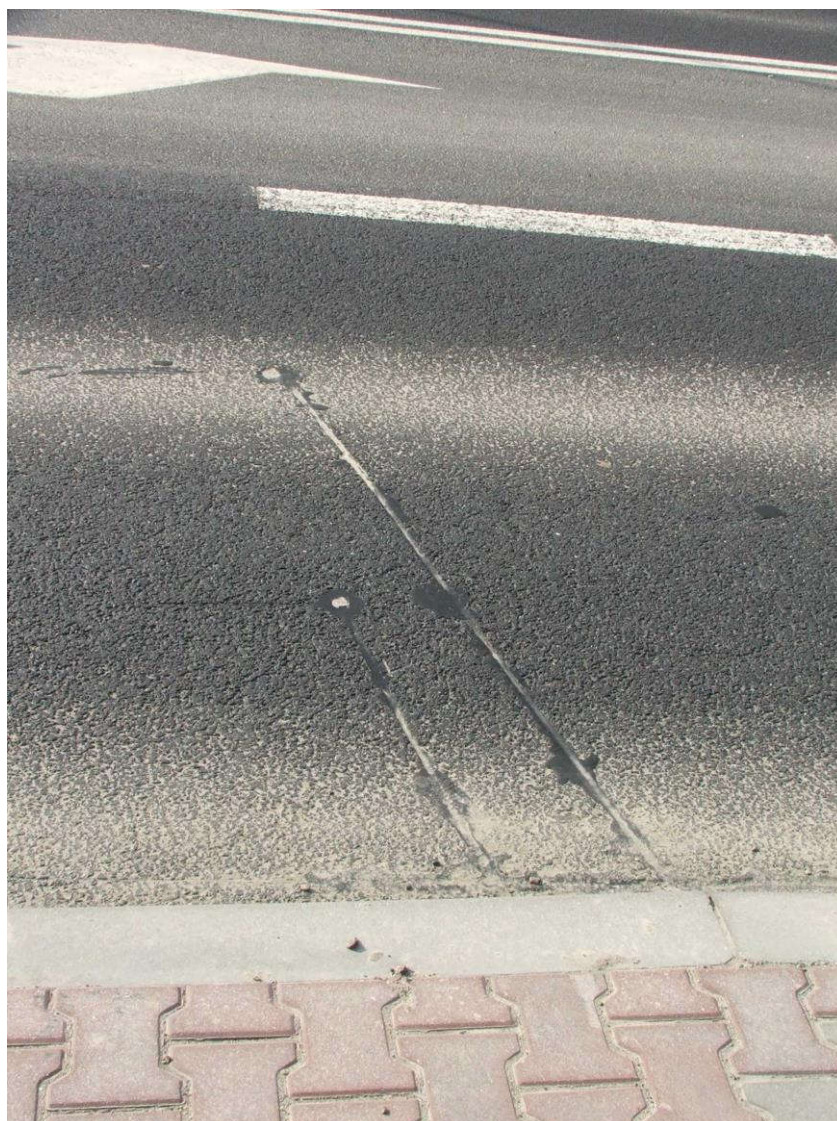
Rysunek 8. Frensory zainstalowane w nawierzchni wlotu „B” (fot. własna).
