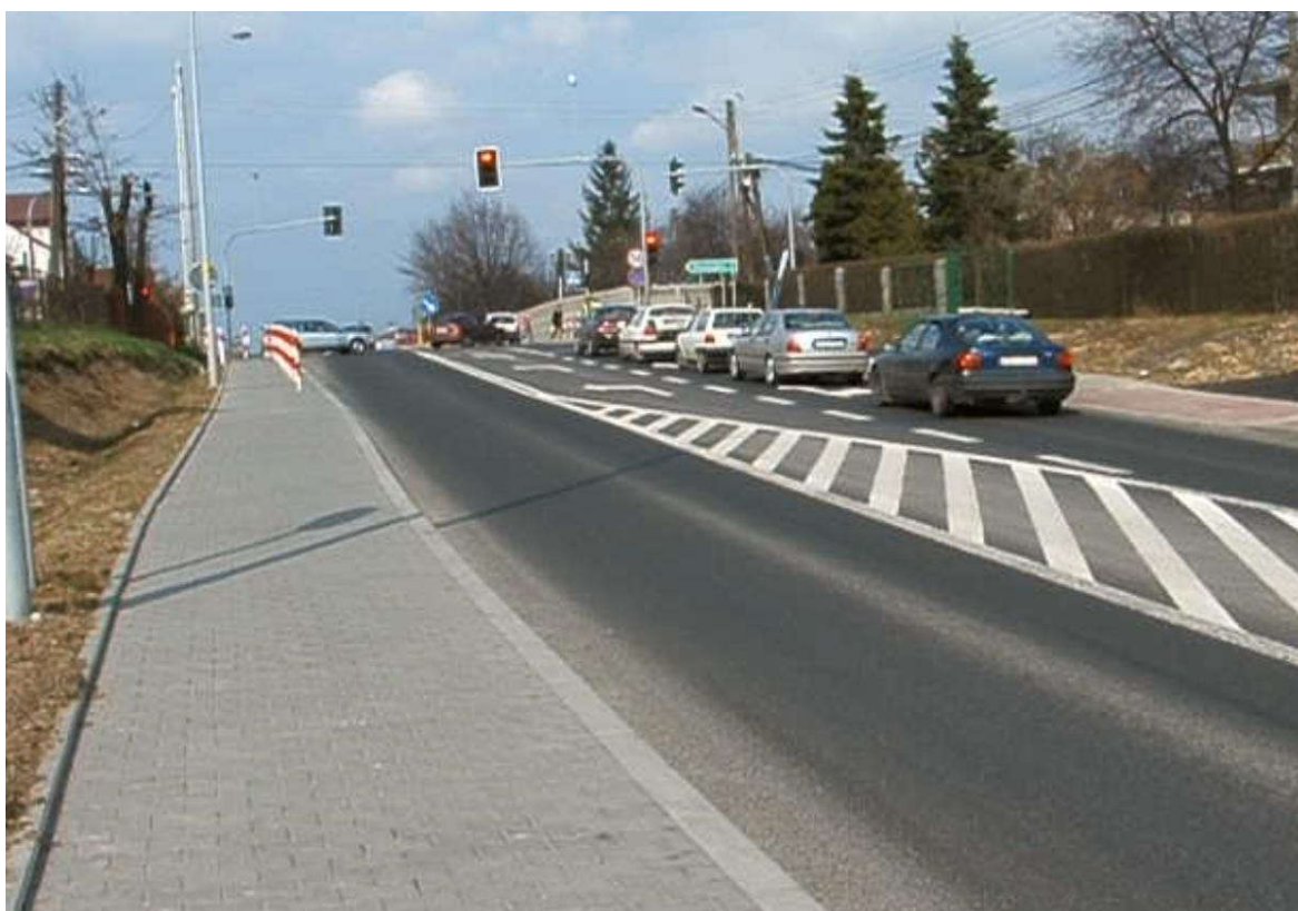
Rysunek 6. Widok wlotu "B" skrzyżowania po przebudowie skrzyżowania (fot. własna).
